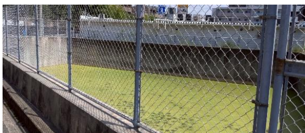
(フェンスで囲われた千里山東4の池)
