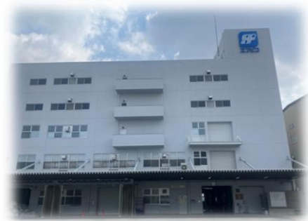
エフピコ西宮選別センター
